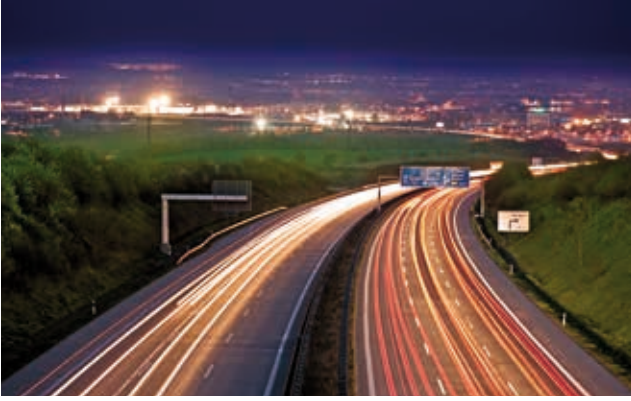
LED aydınlatma Devre dışı kalma kontrolü ve elektrik bağlantısı
